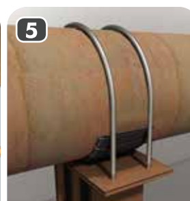
Remise en place de la canalisation sur son support
