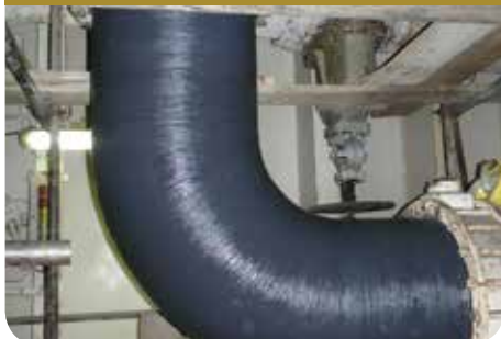
Réparation & renforcement canalisation
